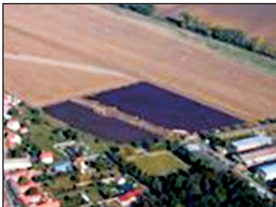
Fot. 1 Moc 800 kWp elektrownia fotowoltaiczna w pobliżu miasta Prostejov Instalacja jest wykonana z modułów Kaneka i falowników KACO. Rok budowy: 2009
