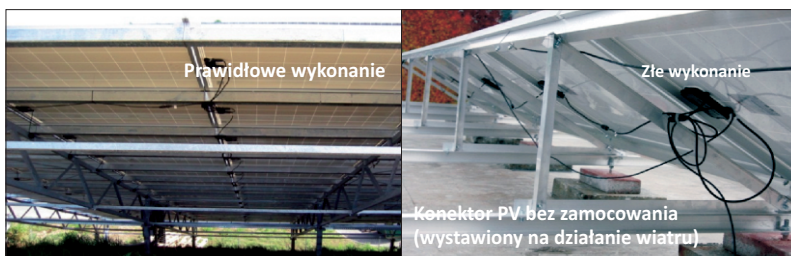
Rys 7. Przykład dobrego wykonania przy prowadzeniu przewodów i przykład złego wykonania instalacji ze złączami konektorowymi bez zamocowania.
