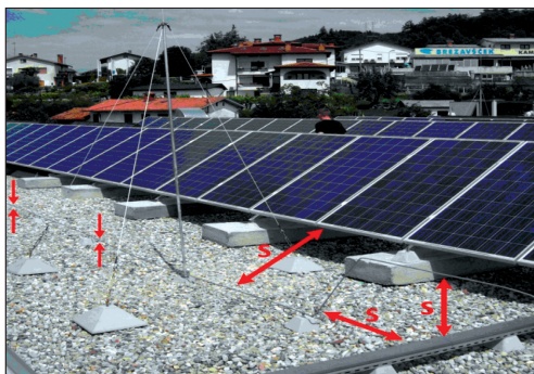
Rys 4: Przykład izolowanego systemu ochrony odgromowej
