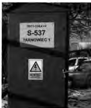
Rys. 1. Tabliczka i przykład oznaczenia zewnętrznego stacji transformatorowej
