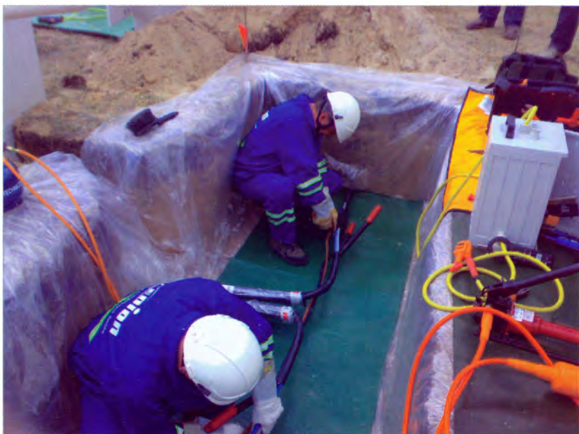
ICOLIM 2008 - Podłączenie nowego złącza kablowego przy zachowaniu przepływu prądu obciążenia w układzie zasilania.
