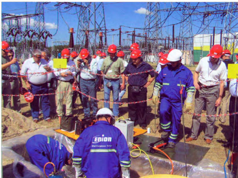
ICOLIM 2008 - Podłączenie nowego złącza kablowego przy zachowaniu przepływu prądu obciążenia w układzie zasilania.
