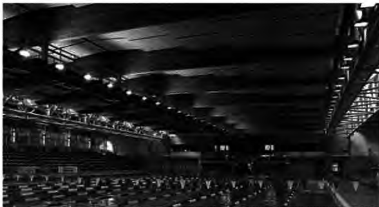
Fot. 1. Kryta Pływalnia Olimpijska na terenie MOSiR "RAWSZCZYŻNA" w Ostrowcu Świętokrzyskim
