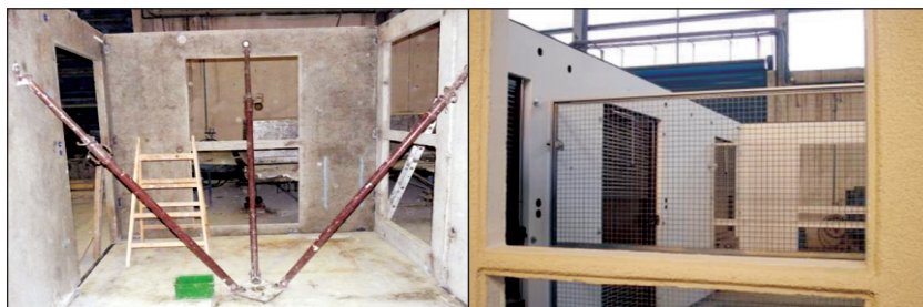
Rys. 16. Technologia montażu i wykańczania korpusu stacji modułowej na hali produkcyjnej
