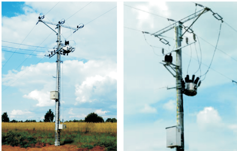
Rys. 3. Przykłady sterowalnych i obserwowalnych rozłączników w sieci napowietrznej SN
