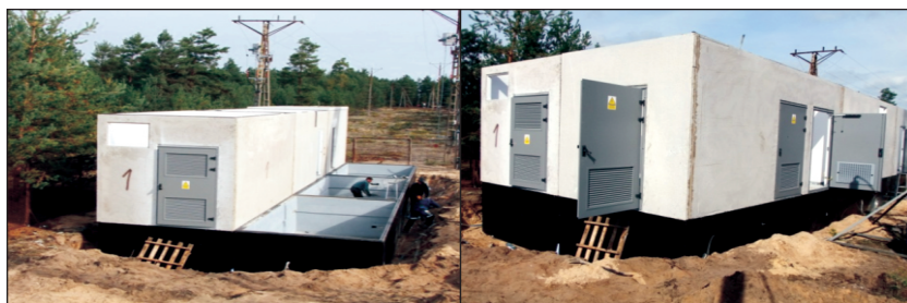
Rys. 15. Zestawianie części naziemnej obiektu
