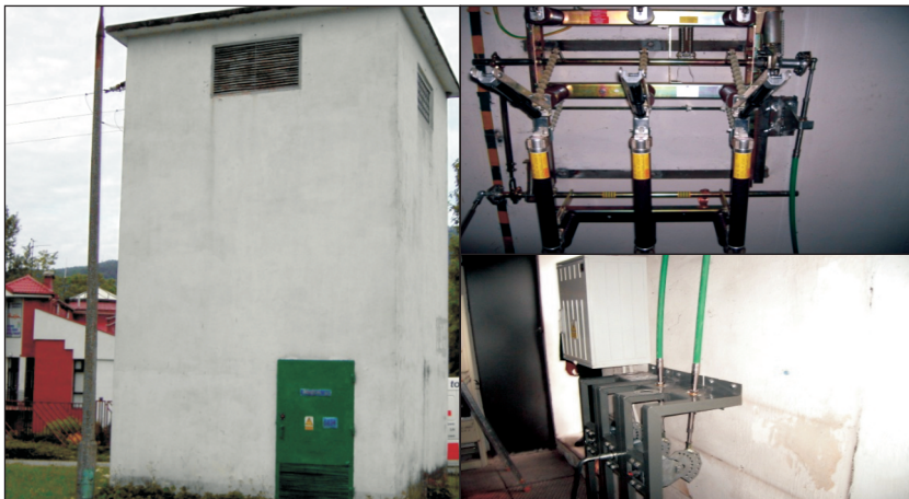
Rys. 8. Modernizacja stacji wieżowej w Międzybrodziu Żywieckim
