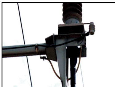
Rys. 1: Przykładowy montaż czujnika pojemnościowego na głowicy kabla WN
