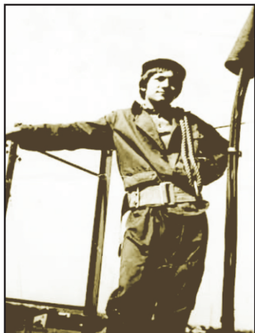
Andrzej Lis jako elektromonter na podeście stacji SN/nN lata 70. ubiegłego wieku.
