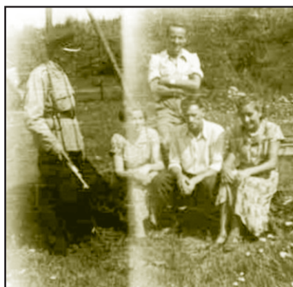
Pani Zyta Pis w otoczeniu Pracowników Energetyki z wartownikiem strzegącym z karabinem infrastruktury krytycznej energetyki. Zdjęcie wykonane przy rozdzielni 110 kV Świerczków.
