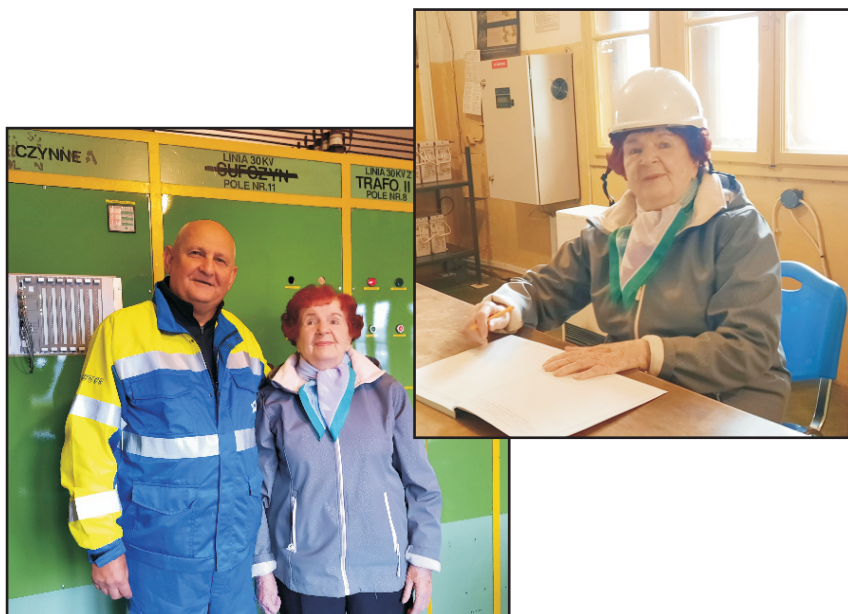
Październik rok 2021 w nastawni 30 kV Stacji Świerczków Pani Zyta Sennik i Pan Wiesław Pękala doświadczeni Dyżurni Stacyjni zapewniają obsługę urządzeń przez prawie 70 lat
