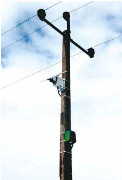
Flite 395 z komunikacją GPRS zasilany z panelu solarnego
