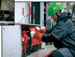
Fot 3. Zabezpieczenie złącza na nN
