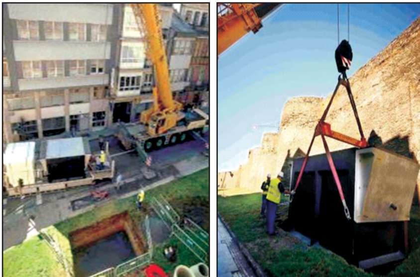
Rys. 9. Sposób posadowienia stacji podziemnej.
