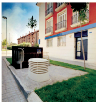
Rys. 5. System stacji podziemnych PFS, wariant stacji dwutransformatorowej z pionowym układem wentylacji.
