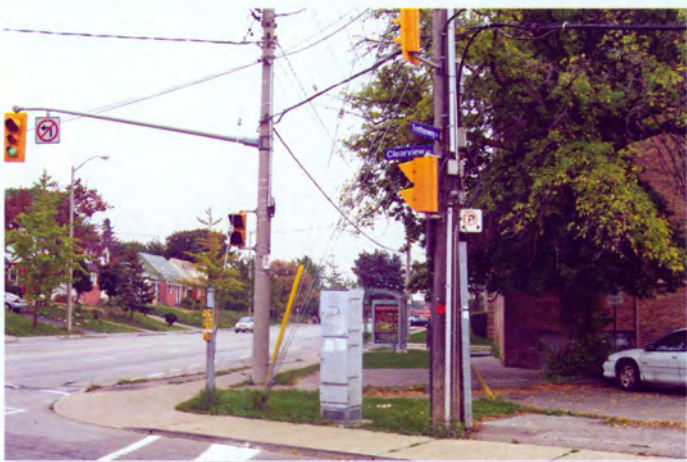
UKŁAD POMIAROWO RÓZLICZENIOWY DLA CZTERECH ODBIORCÓW W TORONTO
