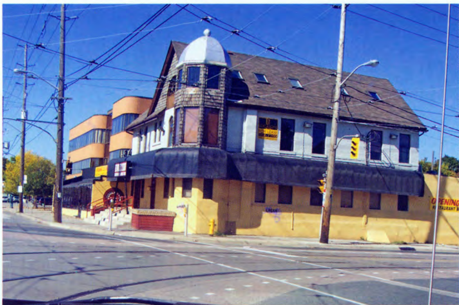
WIDOK SIECI SN/NN NA JEDNEJ Z GŁÓWNYCH ULIC TORONTO
