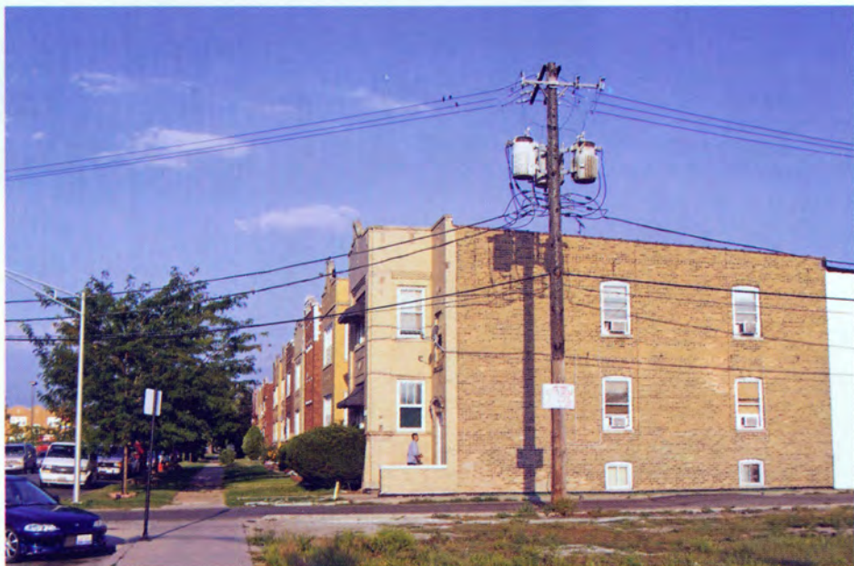
SŁUP DREWNIANY Z TRZEMA TRANSFORMATORAMI SN/NN
