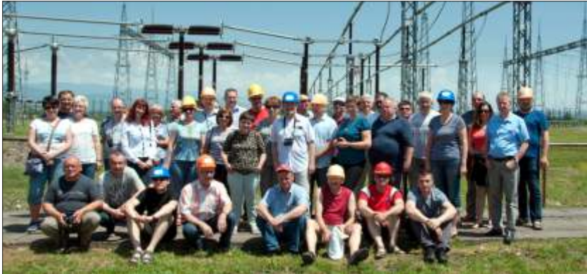
Uczestnicy wyjazdu do Gruzji na tle rozdzielni 500 kV po zakończeniu zwiedzania stacji.
