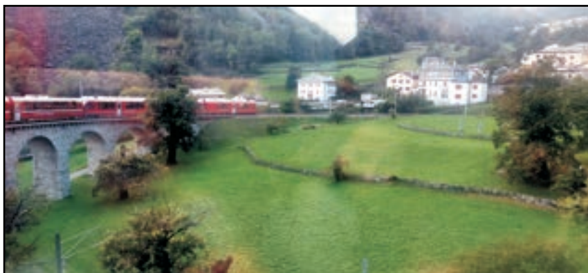
Widok na kamienny wiadukt w Brusio - Kreisviadukt Brusio
